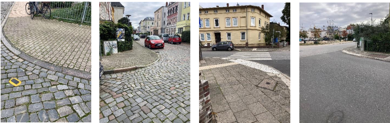
Abbildung 71: Abgesenkte Bordsteine und Bodenindikatoren (Quelle: ZEBAU)
