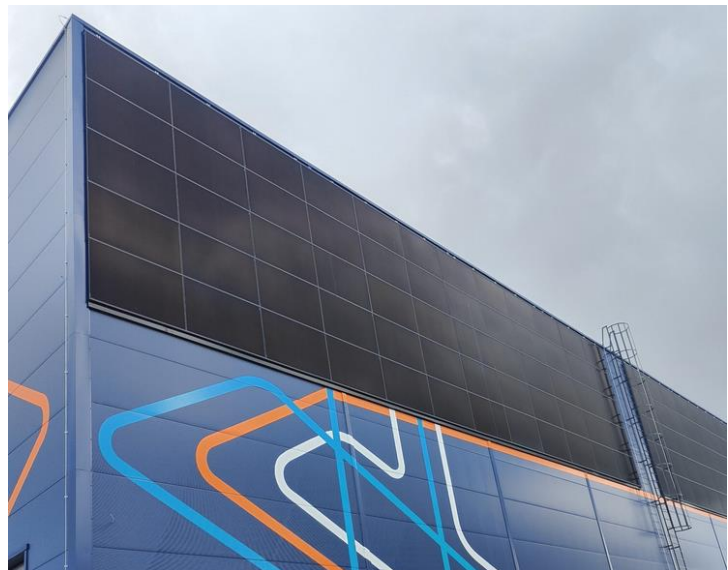
Abbildung 67: Ansicht Fassaden-PV von K2-Systems an Gewerbegebäude (K2Systems: Produktlösungen. https://k2-systems.com/produktloesungen/referenzen/fassadenloesung-an-lagergebaeude-des-estnischen-k2-vertriebspartners-onninen/ (abgerufen am 13.8.2024))
