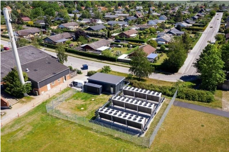
Abbildung 43: 1-MW Luftwärmepumpe in Slagslund Dänemark (Urheber PlanEnergi)
