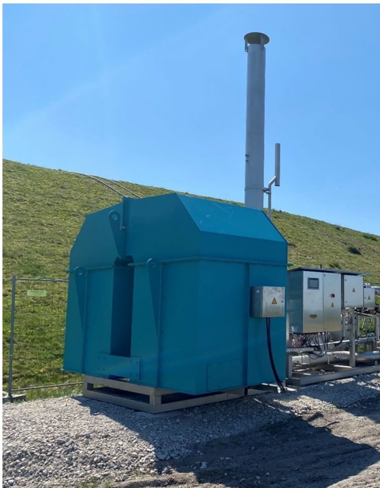
Abbildung 21 LAMBDA Doppelkammer-RTO, 100kWth, 400-2.000 m³/h
