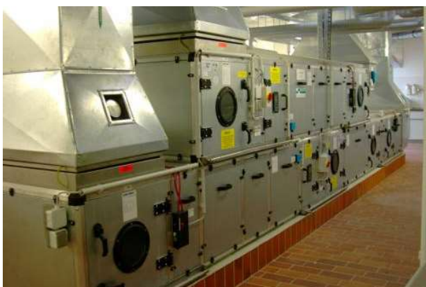
Abb. 4: Raumluftechnische Anlage eines Krankenhauses
