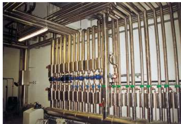
Abb. 5: Warmwasserverteiler
