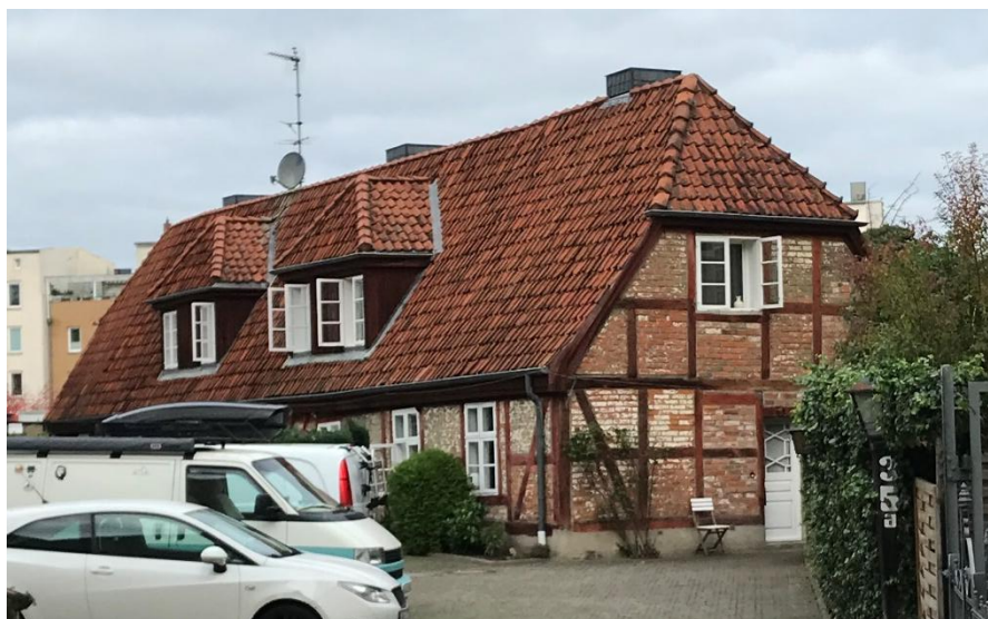
Abbildung 4: Pesthof, Adlerstraße 35a (Quelle: ZEBAU GmbH)
