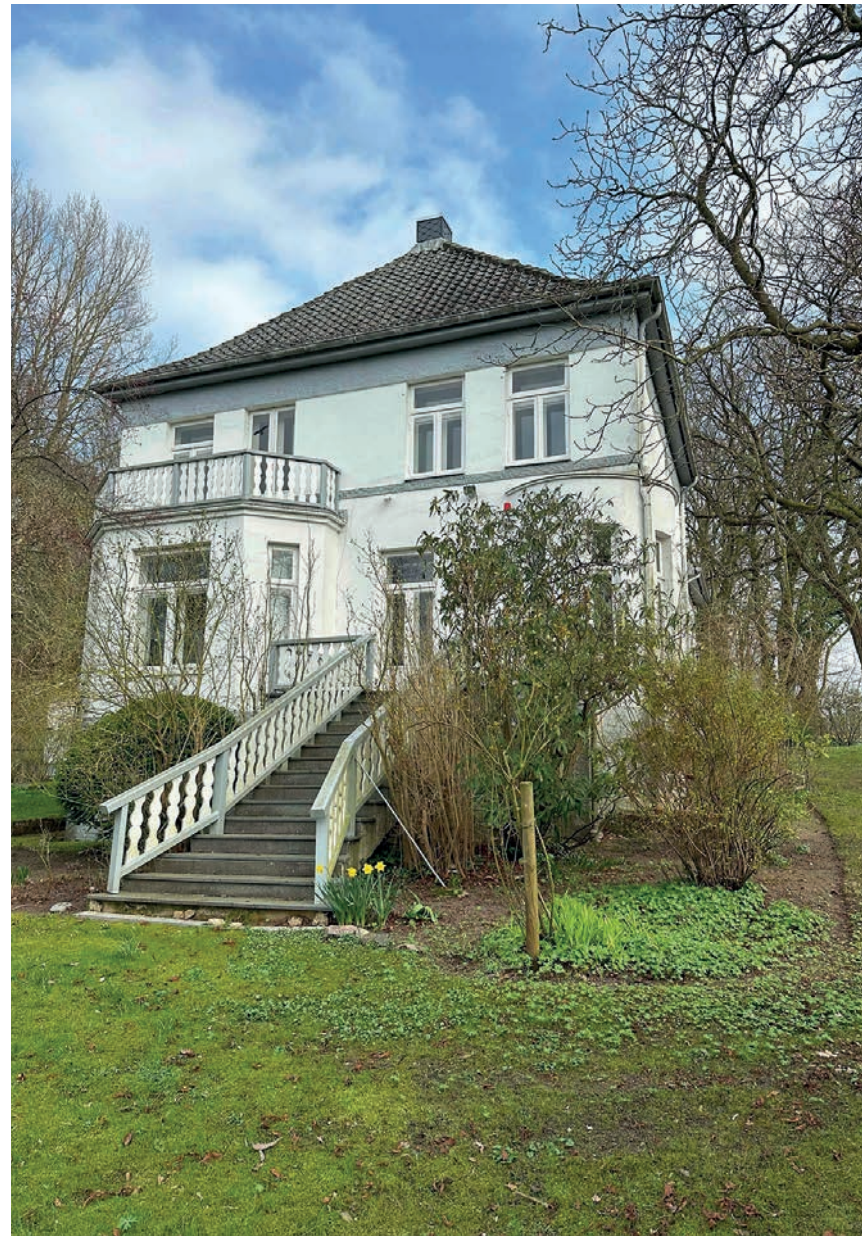
Treppe in den Garten
