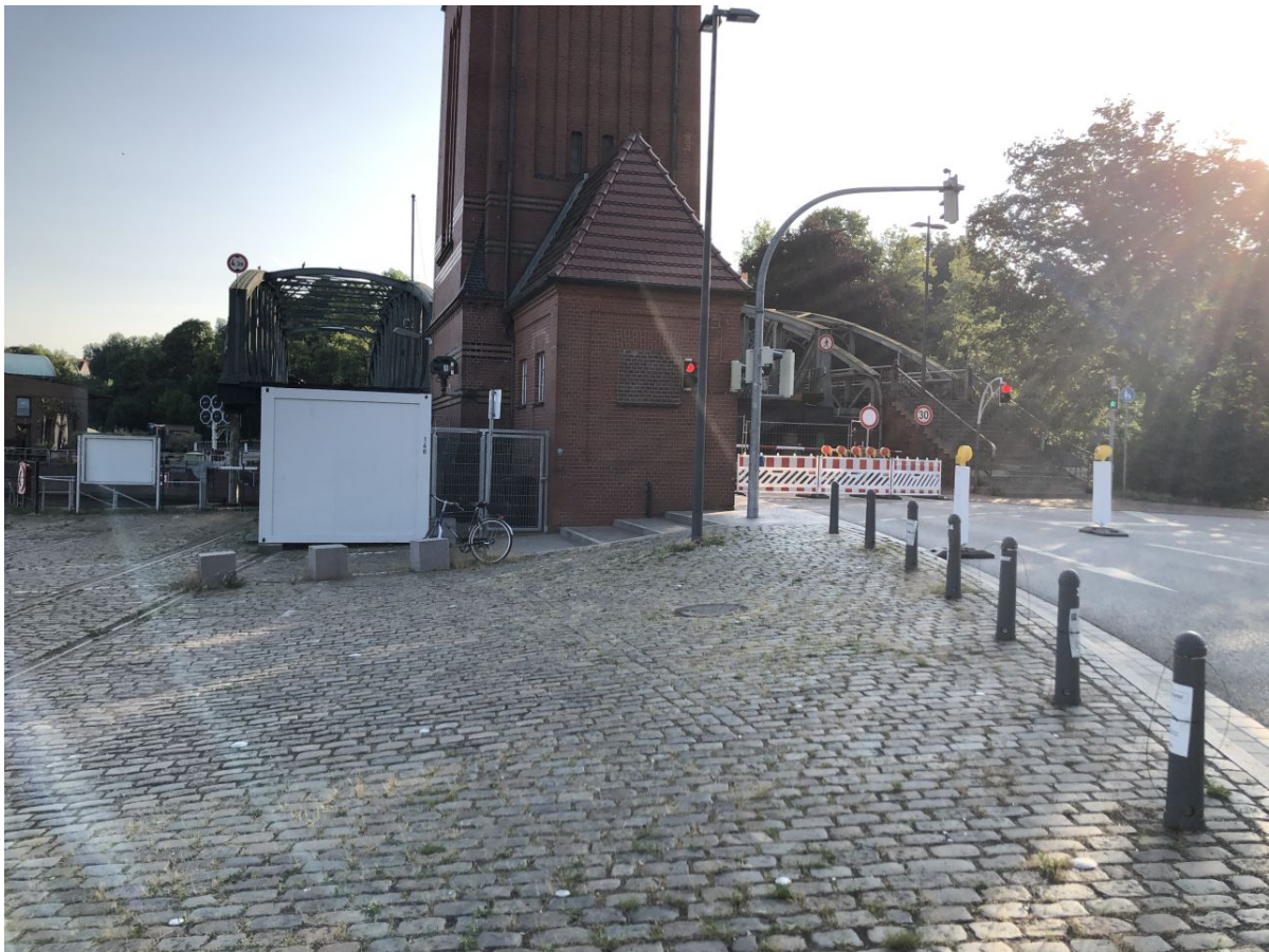
Südliches Hubbrückengebäude von Süden (Untertrave) gesehen
