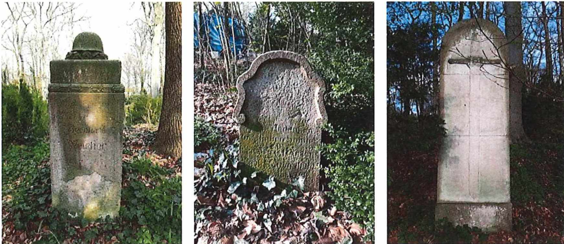
Oberflächenverluste an einzelnen Steinen im Zuge der gesteinsbedingten Verwitterung
