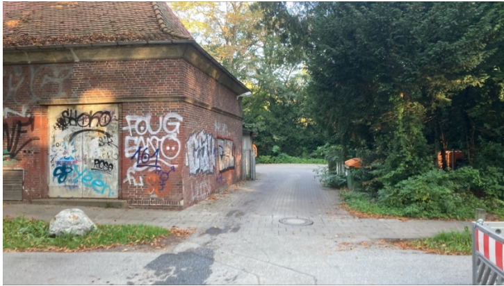
Außenansicht Gebäude Hüntertorallee
