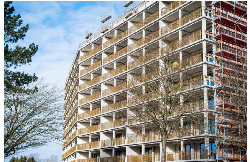
Sanierung Wohnhochhaus Sterntalerweg
