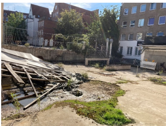
Dachfläche Gebäude Mengstraße 12-14
