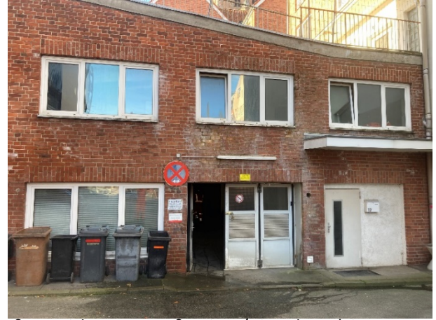
Außenansicht Mengstraße 12-14/Hinterhaus (Ein-
