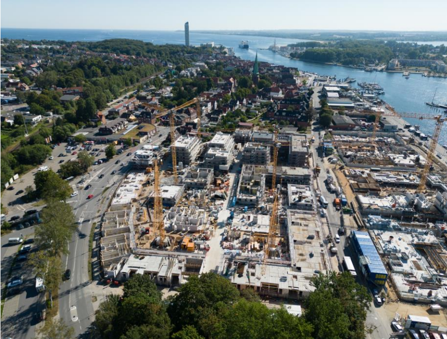
Neubau Auf dem Baggersand
