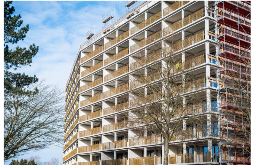
Sanierung Wohnhochhaus Sterntalerweg
