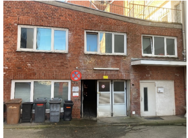
Außenansicht Mengstraße 12-14/Hinterhaus (Ein-
