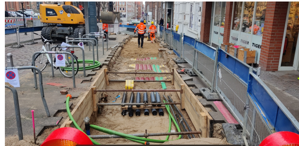
Obere Mengstr. – Rohrgraben Versorgungsleitungen
