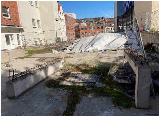
Dachfläche Gebäude Mengstraße 12-14
