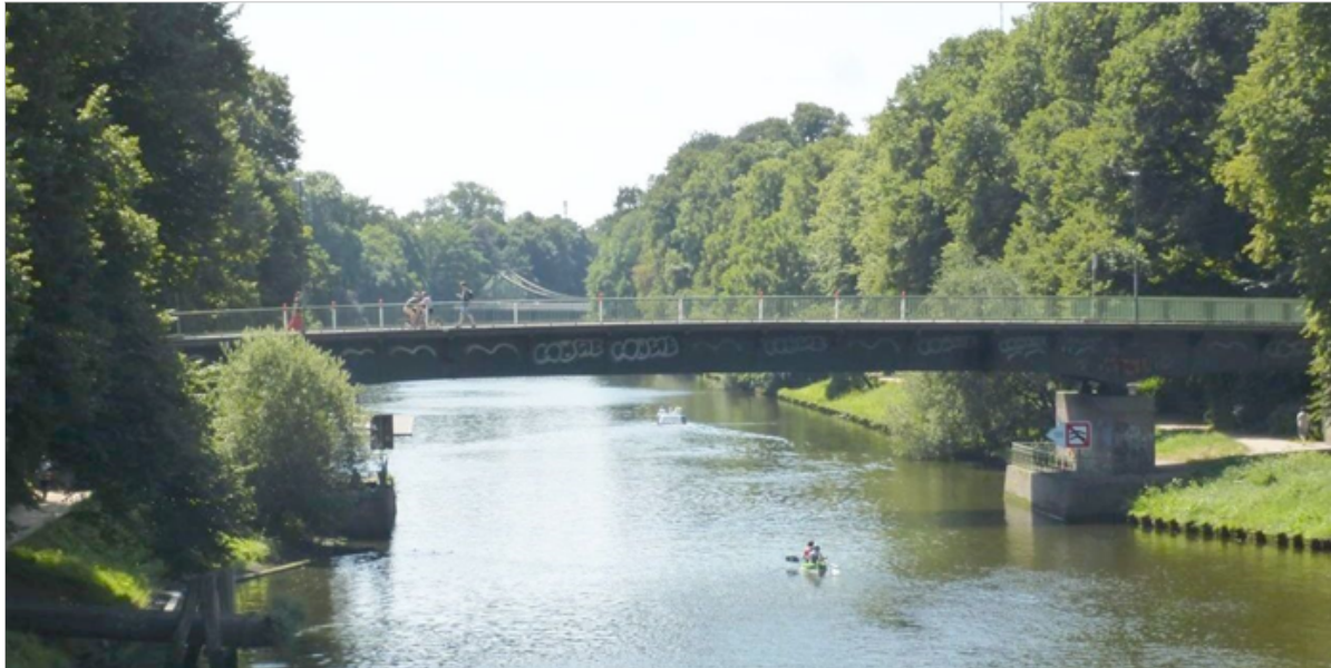
Abb. 2: Seitenansicht Rehderbrücke (Quelle: HL, 5.660)
