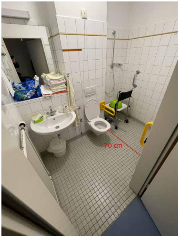
Bewohner-WC: geometrische Einschränkungen aus dem denkmalgeschützten Bauwerk
