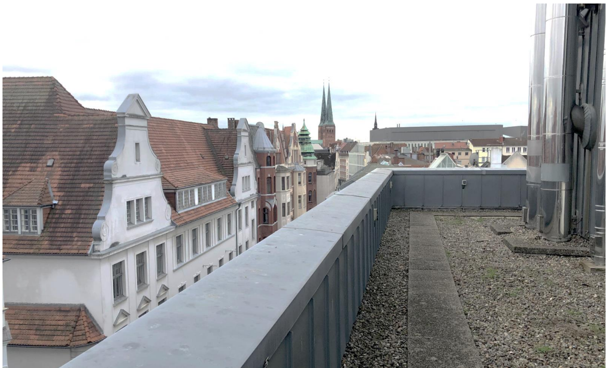
Ansicht Dachgeschoss / Dachterrasse (Richtung Königstraße)
