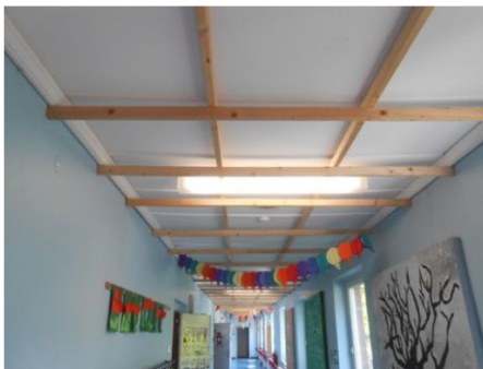
Bestandsaufnahme Abfangung unter sich durchbiegender Decke
