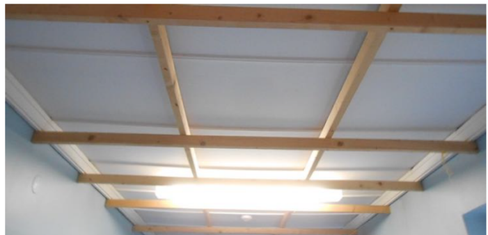
Bestandsaufnahme Abfangung unter sich durchbiegender Decke
