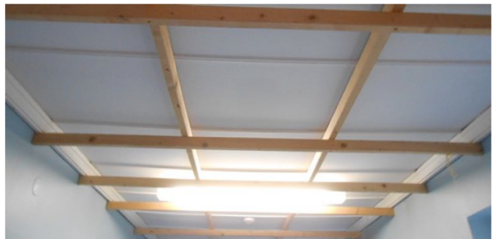
Bestandsaufnahme Abfangung unter sich durchbiegender Decke
