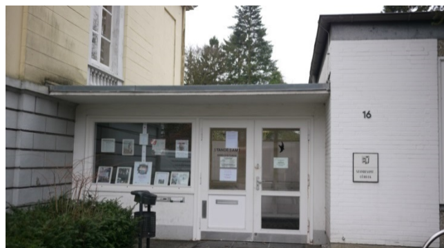
Haupteingang und Verbindungsbauwerk
