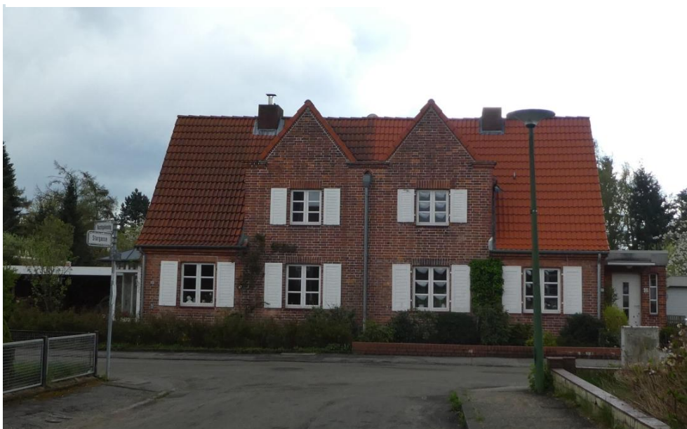
Kopfbau Nachtigallenstieg 16 und 18
