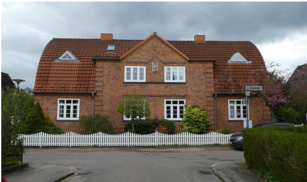
Kopfbau Amselweg 5 und 7
