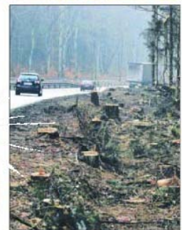
An der Wesloer Landstraße sind Bäume gefällt worden. Hier sollen zwei Amphibientunnel entstehen.
