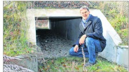
Jens Sommerburg vom Landesbetrieb Straßenbau und Verkehr zeigt einen Tunnel an der Umgehungsstraße. Fotos: Archiv, Kröger, Künzel
