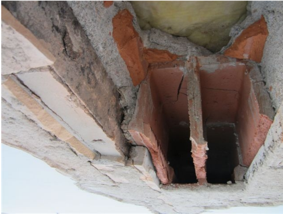
Auflagersituation Ziegelhohlkörper
