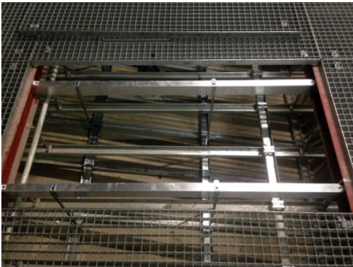
Übersicht der Struktur eines sanierten Deckenfeldes
