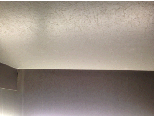
Traufbereich der Saaldecke mit Streiflicht und Abzeichnung der punktuellen Überarbeitung
