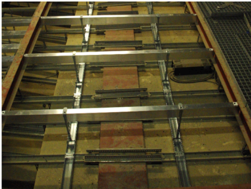
Ersatz der alten Überbrückung im Bereich der Stahlträger durch neue Grundprofile und Abhängung
