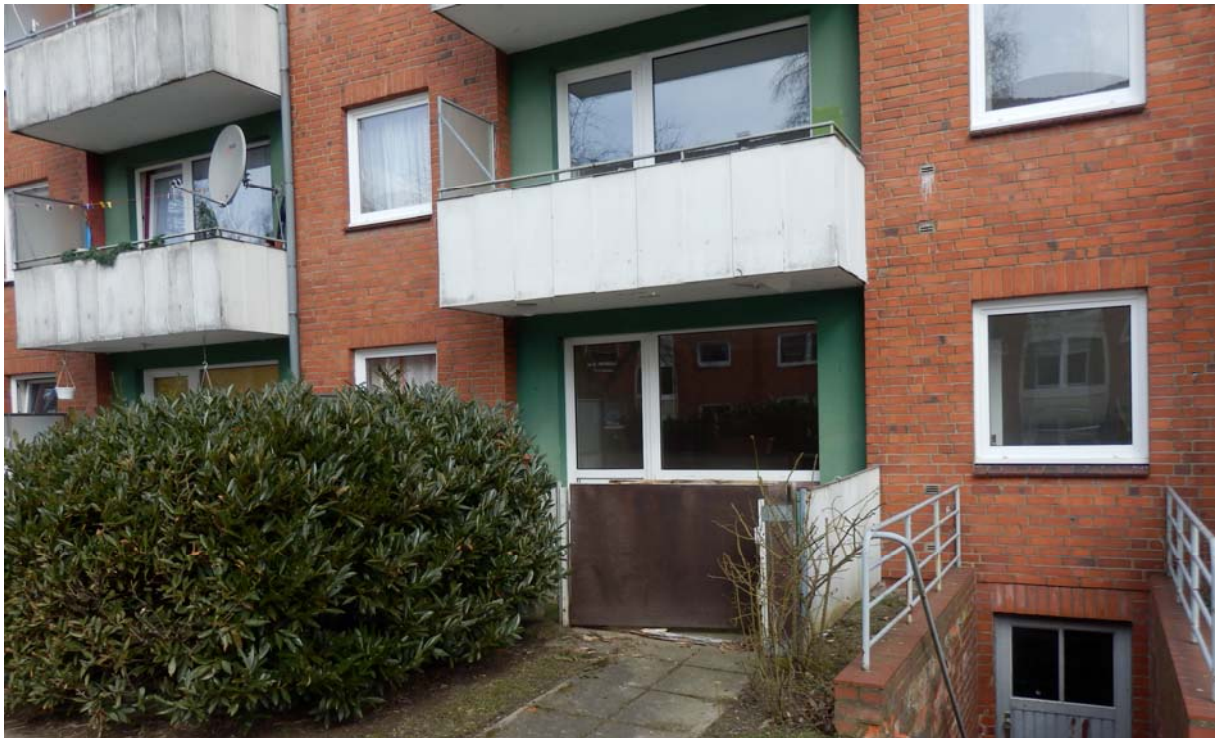
Geschosswohnungsbau mit Modernisierungsbedarf
