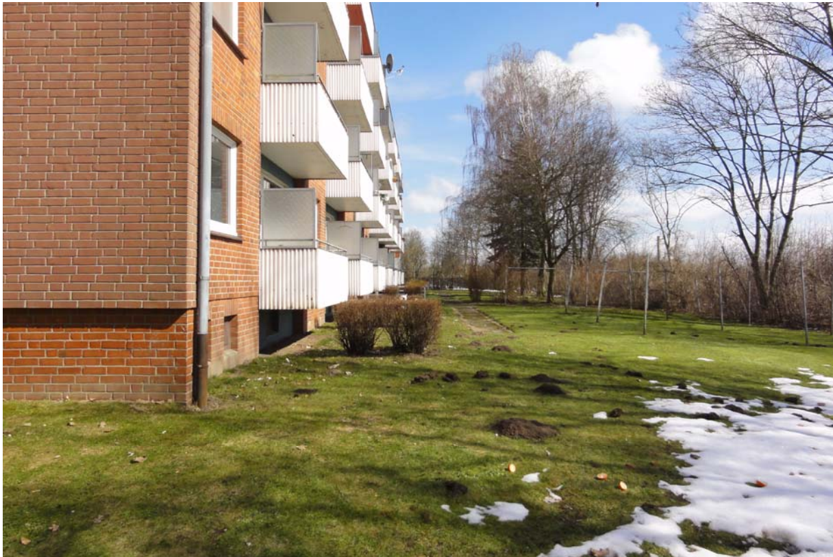
Unattraktives Wohnumfeld der Zeilenbauten
