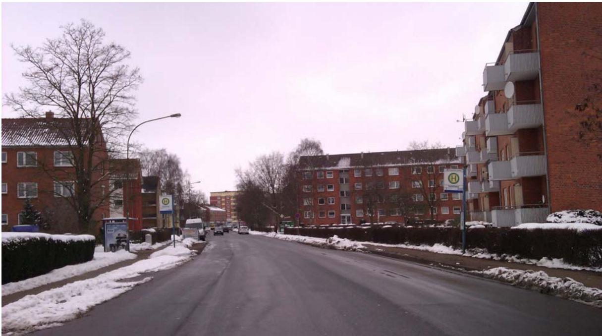
Überdimensionierter Straßenraum (Andersenring)
