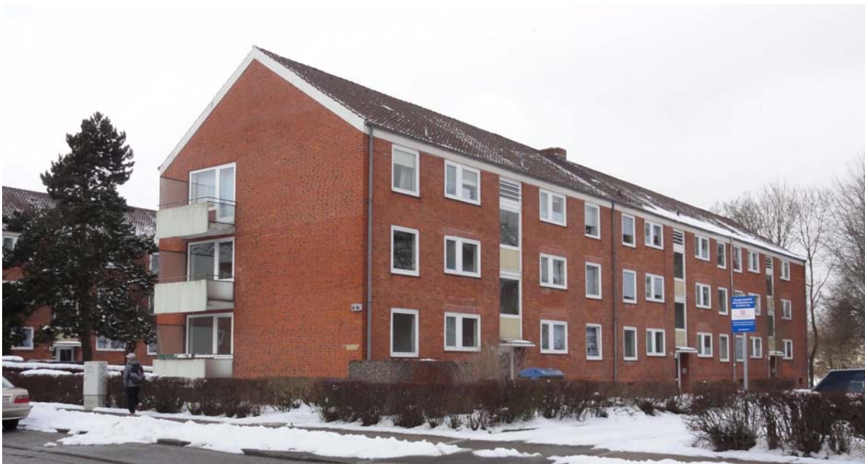
Prägende Zeilenbauten des Geschosswohnungsbaus im Untersuchungsgebiet
