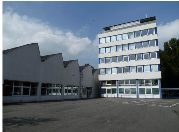
Abbildung 12: Baggersand 17 - Unternutzung/ Leerstand
