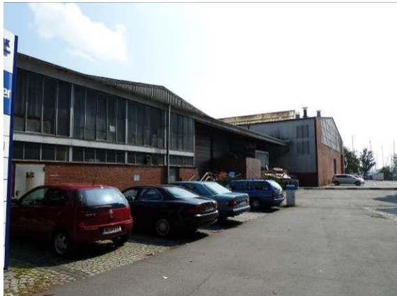
Abbildung 11: Baggersand 15 - Unternutzung/ Leerstand
